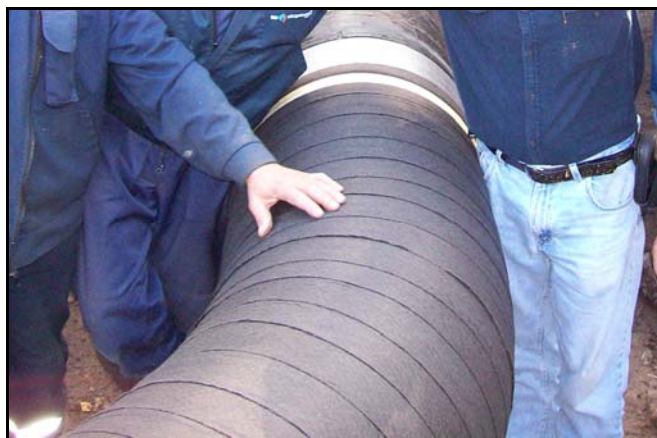
L'utilisation de l'ENVELOPPE POLYGUARD SP-6 est également recommandée pour une meilleure résistance à la tension du sol.
