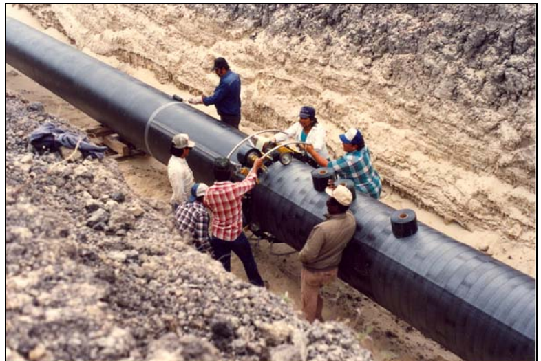
L'applicazione a macchina dell'RD-6 è vivamente consigliata quando possibile. La tensione aumentata dell'applicazione a macchina è di aiuto nella resistenza alla tensione del terreno.
