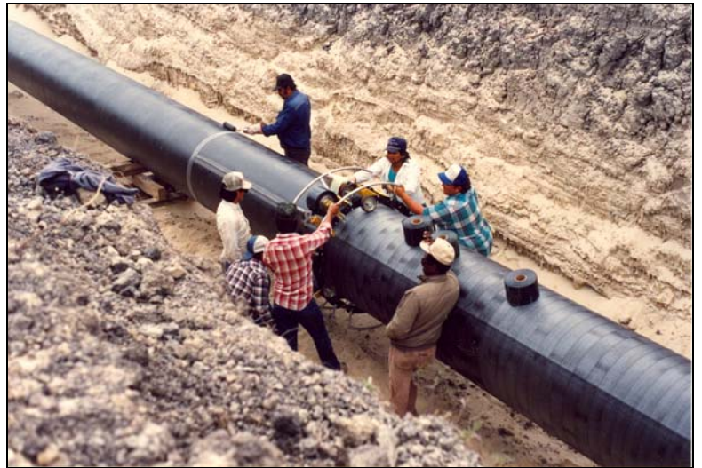
Se recomienda especialmente la aplicación del RD-6 con máquina donde sea posible. La tensión mayor de la aplicación con máquina incrementa la resistencia a la tensión del terreno.
