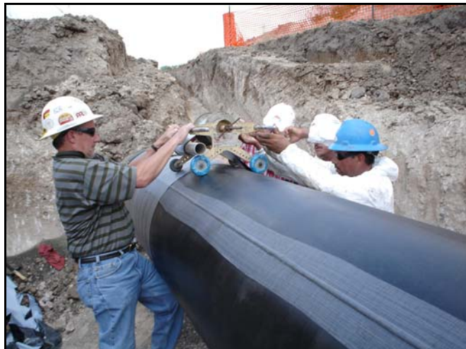
El uso de una maquina facilita la tensión y mejor su adherencia. También ayuda contra el suelo.
