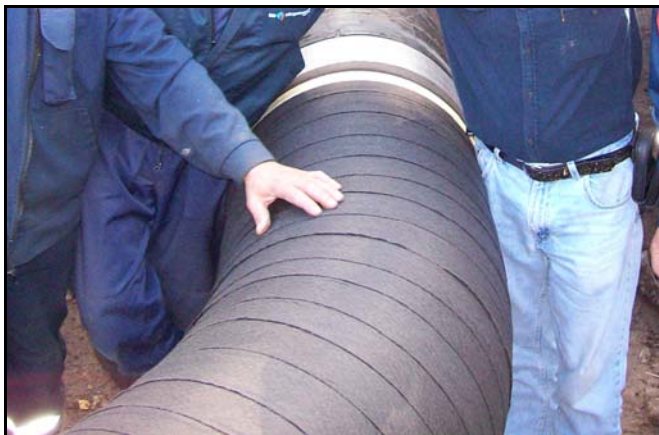
POLYGUARD SP6 OUTERWRAP se recomienda para resistencia contra el suelo.
