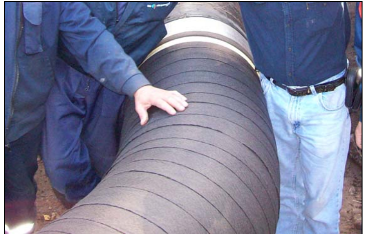
El SP-6 reducirá la deformación de los sistemas de revestimiento contra la corrosión causada por la tensión del terreno. Actúa como un plano de deslizamiento para aliviar dicha tensión.
