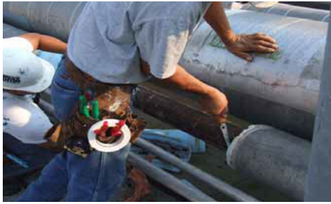
Tubería después de la limpieza
